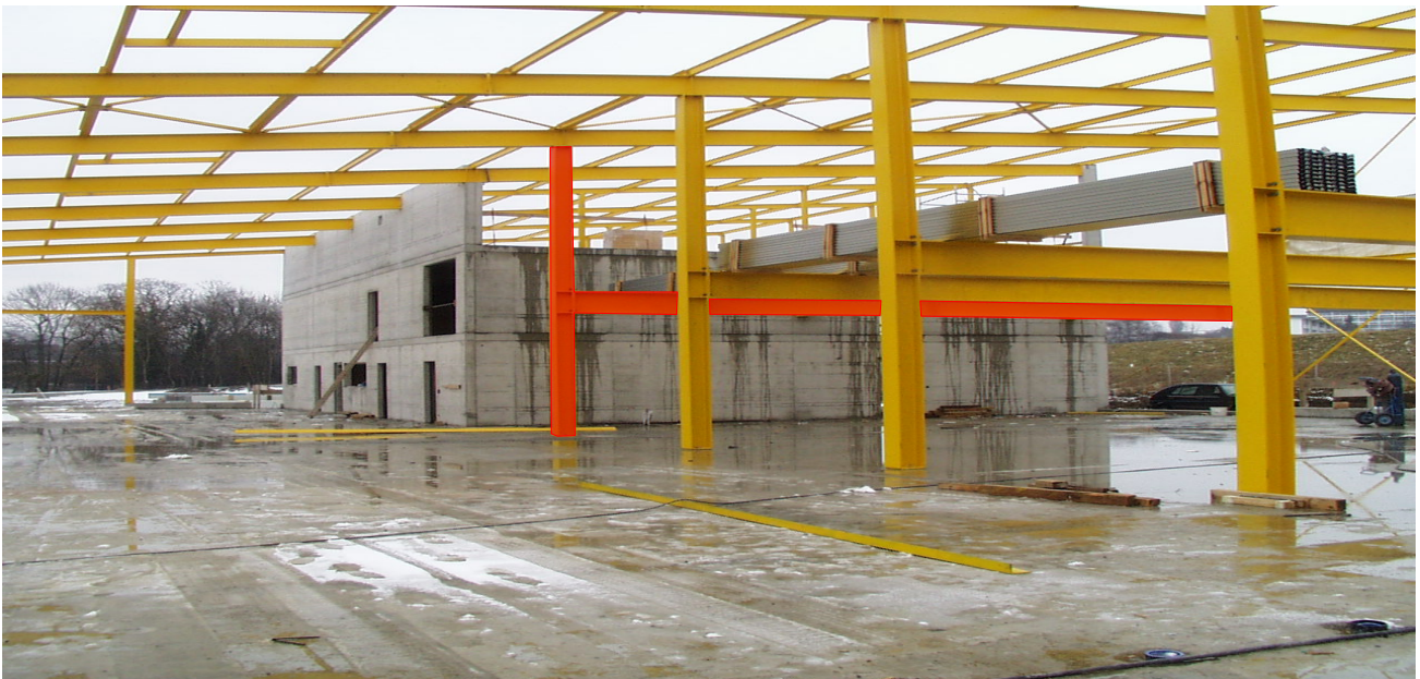
Figure 7 – mise en évidence de la partie rigide des cadres (avant pose des tôles et bétonnage de la dalle mixte)
