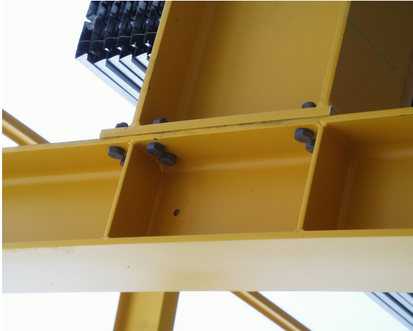
Figure 5 – Détail A : assemblage rigide
