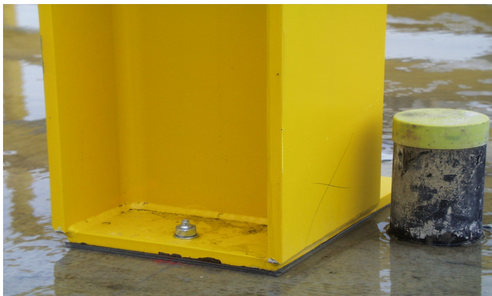
Figure 8 – Détail F, assemblage poteau-fondation articulé
